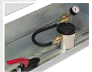
• Prüfung eines Sicherheitsventils mit einem Ventilprüfkopf.
